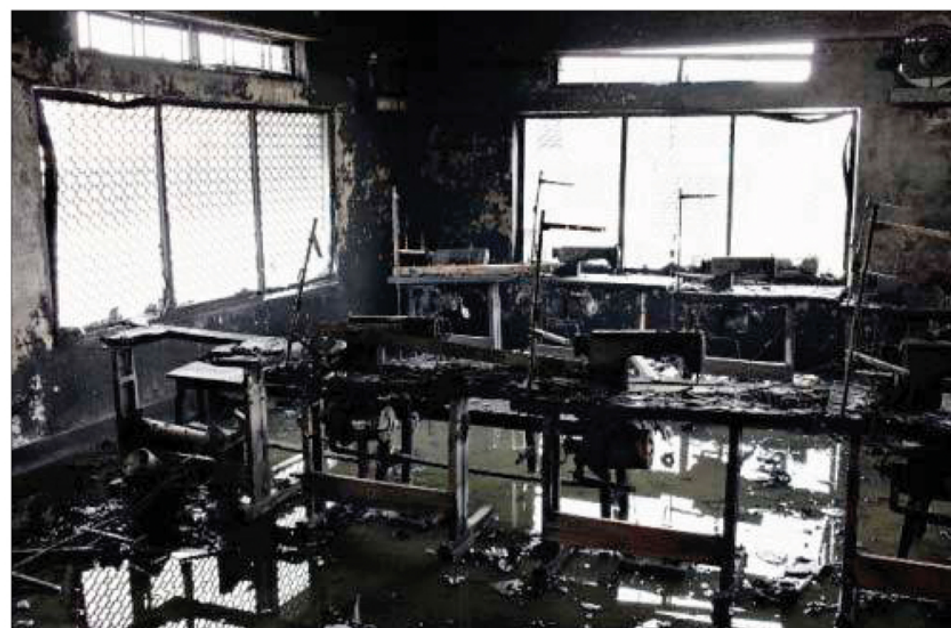
UDBRÆNDT. 21 mennesker fra natholdet på en tekstilfabrik i Gazipur døde af røgforgiftning, da der udbrød brand. Arbejderne var låst inde på fabrikken og havde derfor ikke mulighed for at slippe ud.
